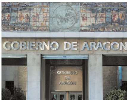
Edificio administrativo del Gobierno de Aragón en la plaza de San Pedro Nolasco, Zaragoza.
